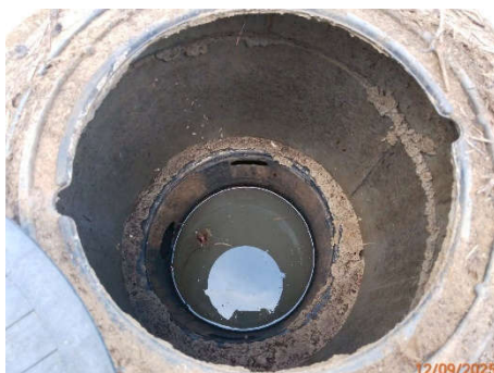
บ่อพักน้ำก่อนผ่านระบบบำบัดน้ำเสียอาคารที่พักผู้โดยสาร ชุดที่ 2
