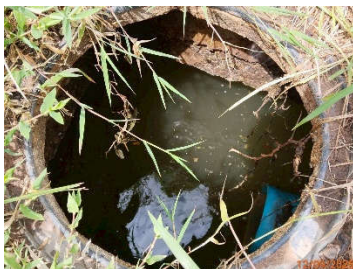
บ่อพักน้ำก่อนผ่านระบบบำบัดน้ำเสียอาคารที่พักผู้โดยสาร ชุดที่ 4
