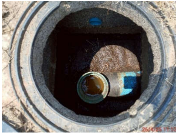
บ่อกักน้ำก่อนผ่านระบบบำบัดน้ำเสียอาคารที่พักผู้โดยสาร ชุดที่ 3
